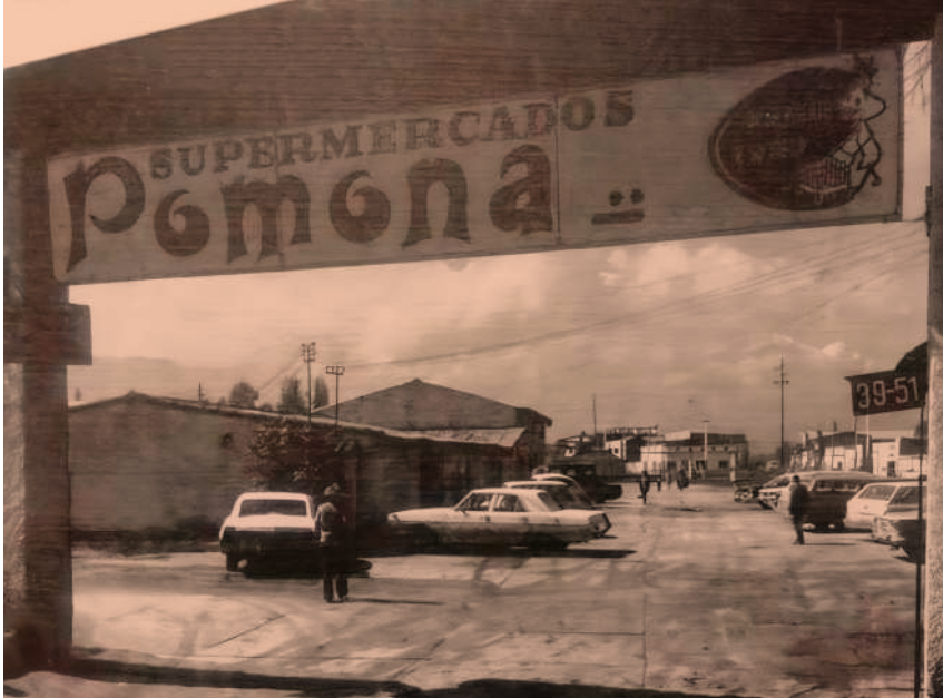
(1967) Supermercado ubicado en el terreno donde se construiría el Centro Comercial Iserra 100 en 1996.
